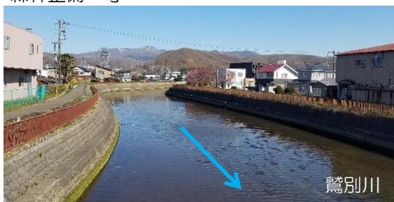
河道掘削、樹木伐採（胆振総合振興局）
