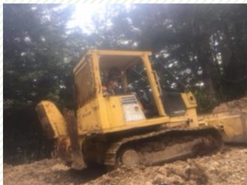
【ブルドーザーを作業現場へ移動中】
