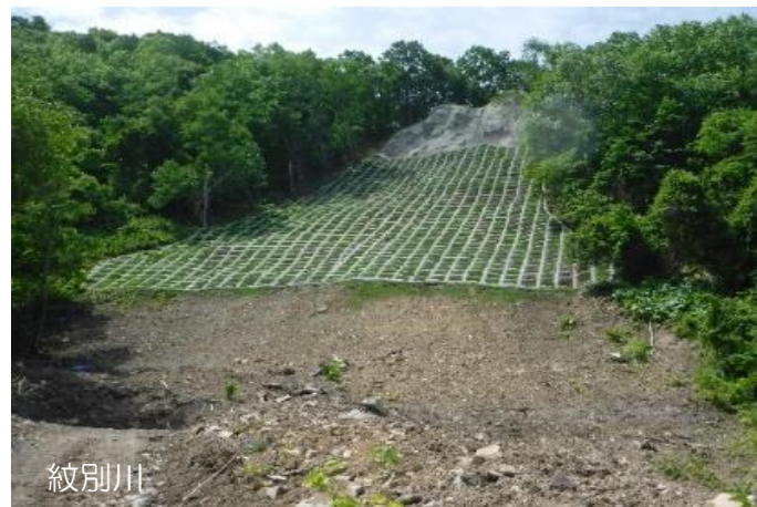
国有林内における山腹工の整備（後志森林管理署）
