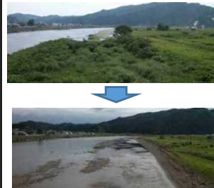
河道内樹木を伐採し洪水の疎通能力を向上
