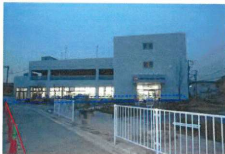
雨水貯留浸透施設の事例【横浜市内】
