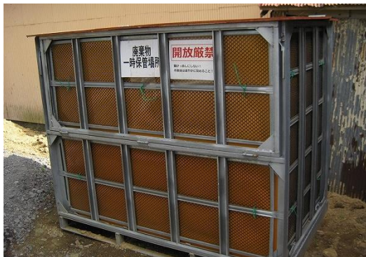
コンテナを改造し自作した廃棄物一時保管場所
