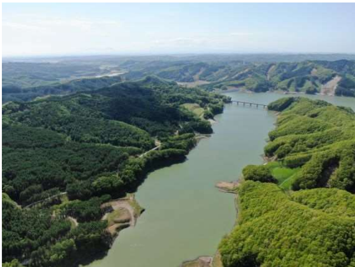
厚真町 厚幌ダム
