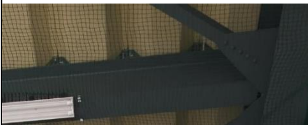
天井にネットを張り、鳥類の侵入防止
