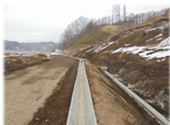
<農道・用水路・排水路の復旧>
