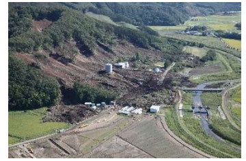
浄水場の被害 (厚真町)
