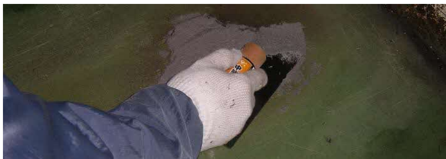
プライマー塗布後、穴埋め
