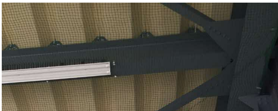
天井にネットを張り、鳥類の侵入防止(写真2)
