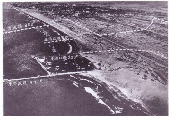
建設途中の苫小牧港(1955年)
