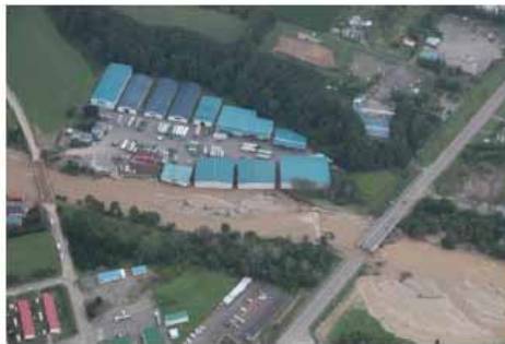
多量の土砂流入状況(ペケレベツ川)
