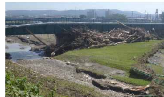
流木による断面阻害状況(久慈川)
