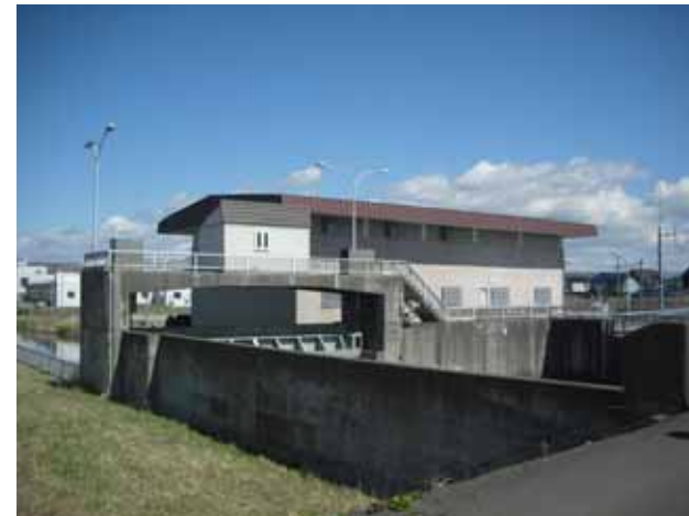
古川排水機場（静内川）
