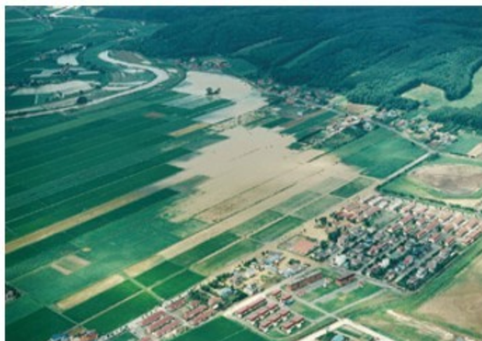
平成4年8月台風10号による被災写真
