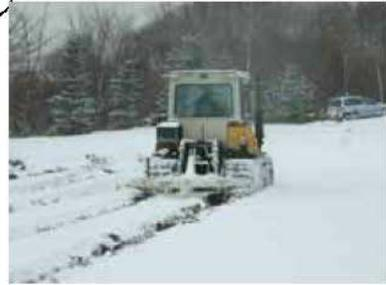
しばれる時期(表面水が凍っている時期)に施工することで、ぬかるみにこだわらず作業ができます。土壌構造を痛めません。冬季施工することで、春先の融雪水の排水効果が期待できます。
