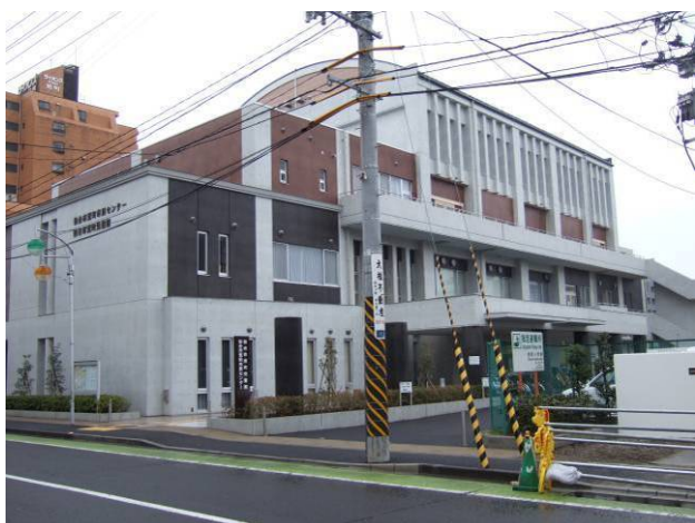
避難所：若林区荒町市民センター
