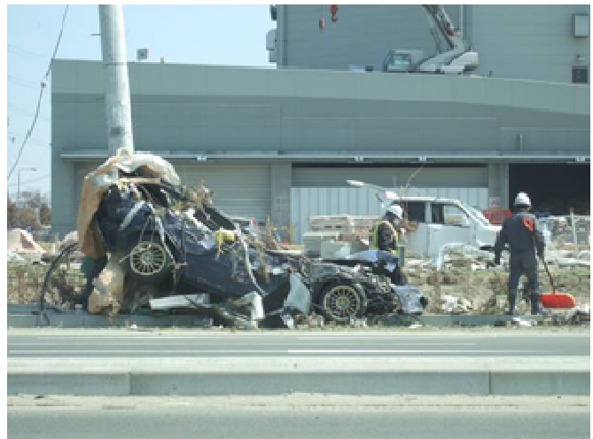
瓦礫等の撤去作業状況（仙台港周辺）
