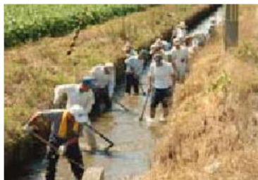
＜水路の泥上げ＞
