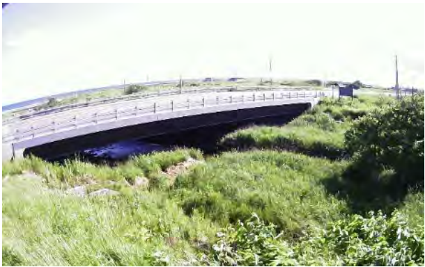
(別々川) 簡易型河川監視カメラによる映像提供
