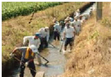
＜水路の泥上げ＞
