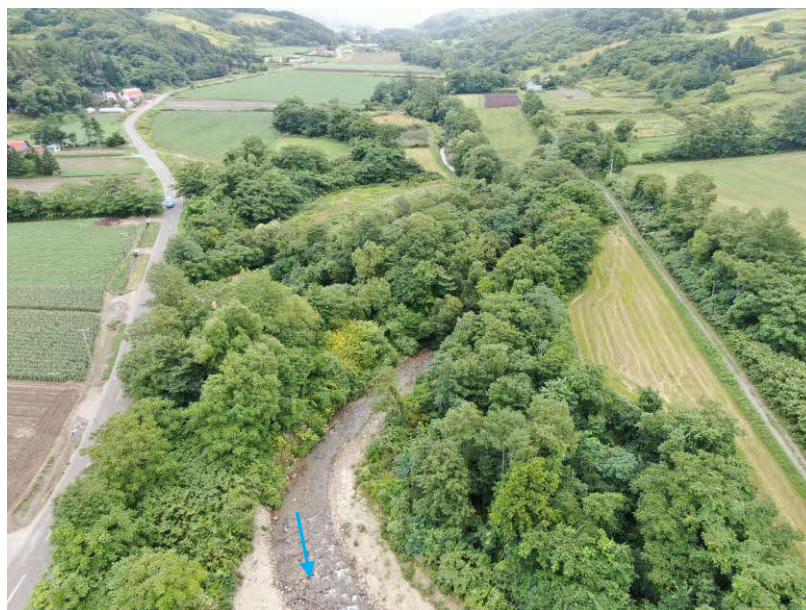
写真 1-11 上流域の河道状況 （気門別小橋より上流を望む 令和元年 8 月撮影）
