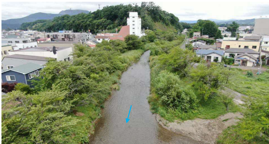
写真 1-15 下流域の河道状況 (錦橋より上流を望む 令和元年8月撮影)
