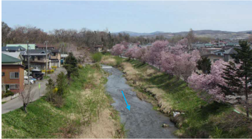
写真 1-10 館山橋から上流を望む（平成 29 年 5 月撮影）
