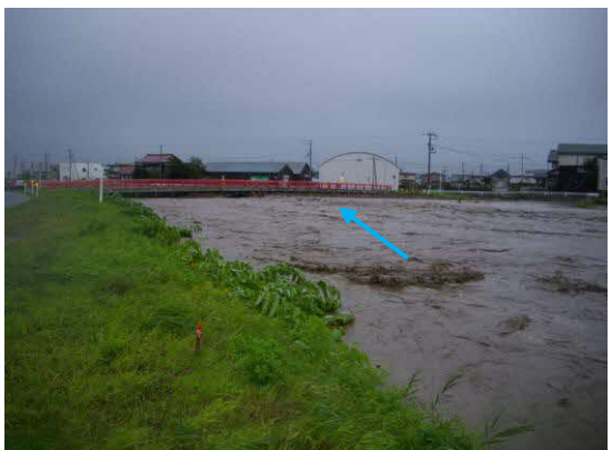
写真 1-8 市道新橋付近 (平成29年9月出水)
