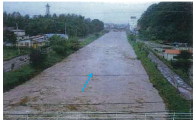
写真 1-7 国道館山橋付近 (昭和56年8月出水)
