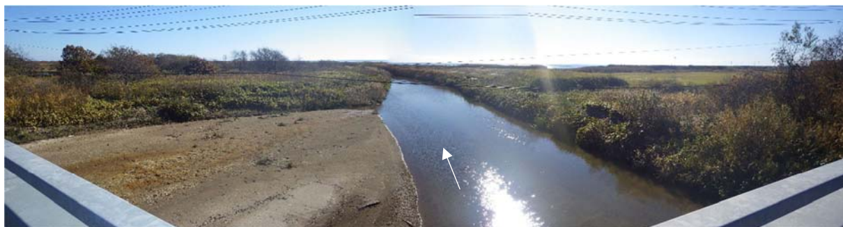
下流域の河道状況（国道オヨロ橋より下流）
