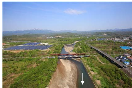
白老川 国道白老大橋付近から上流
