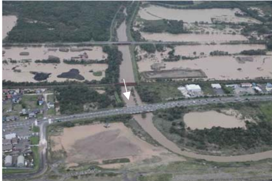
ウヨロ川 平成 26 年 9 月豪雨浸水状況 国道オヨロ橋付近から上流
