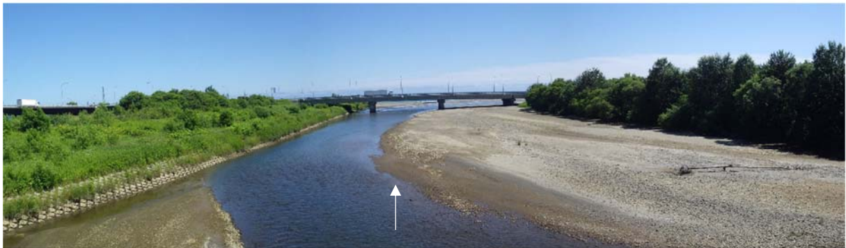
下流域の河道状況（町道白老橋下流）
