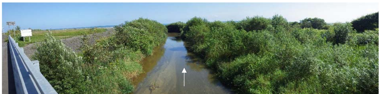
下流域の河道状況（国道風雨別橋より下流）
