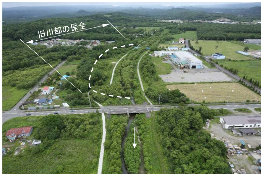
下流域の河道状況（町道新ブウベツ橋より上流）
