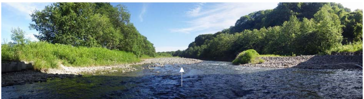
中流域の河道状況（道央自動車道高架下より下流）
