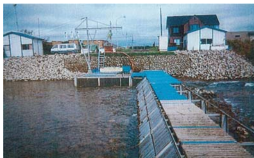
ウライの設置状況
