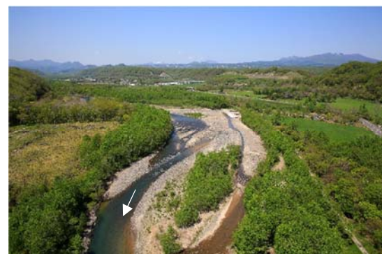
白老川 第二落差工付近から上流
