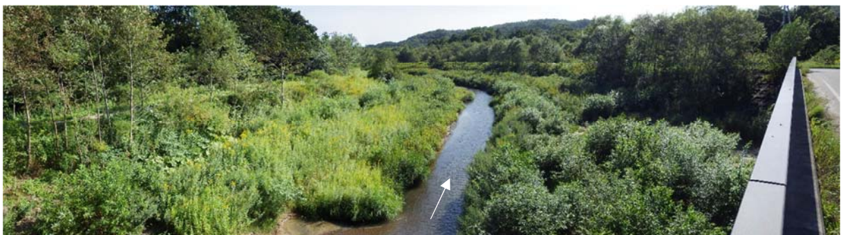
中流域の河道状況（町道風雨別二号橋より下流）
