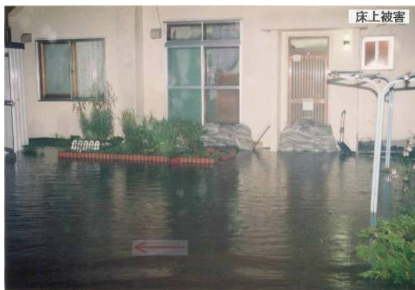
平成 7 年 8 月洪水による家屋浸水
