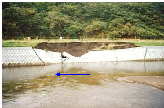
(H7 護岸崩壊写真)
