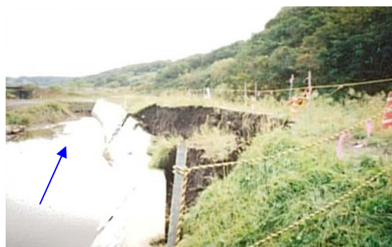
(H7 護岸崩壊写真)
