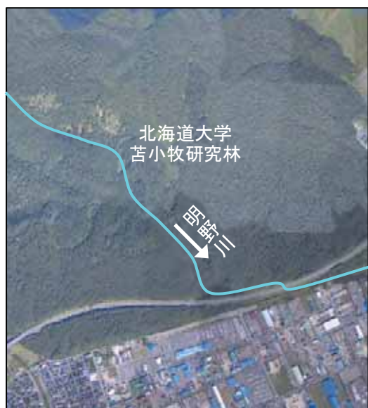
写真 1-23 上空から見る明野川上流部の状況
