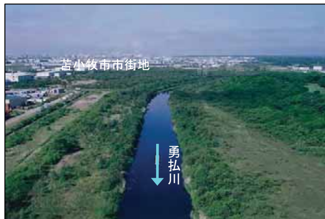
写真 1-16 勇払川上流域の状況（市道夕振大橋上流）
