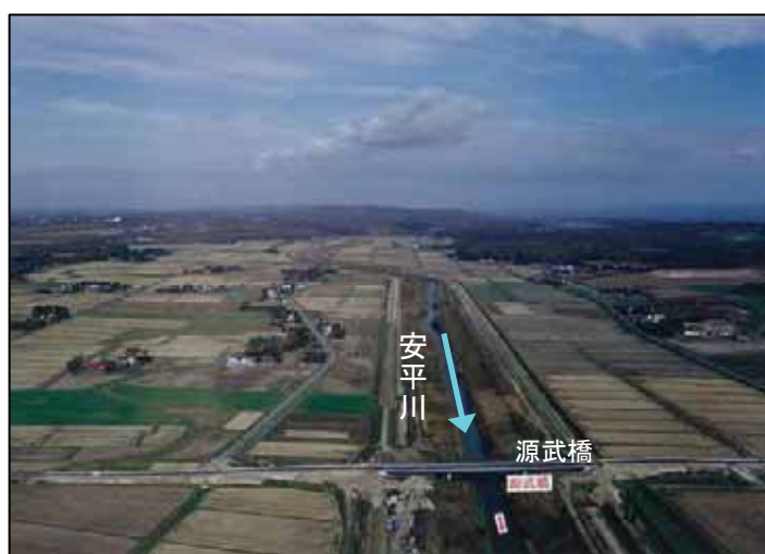
写真 1-12 安平川中流域の状況（道道源武橋 げんぶ 付近）
