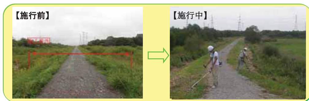
図 3-2 堤防の除草の状況
