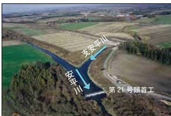
写真 1-22 支安平川下流域の状況（安平川合流点付近）
