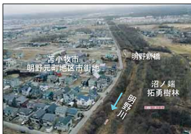
写真 1-24 明野川中流域の状況（市道明野新橋付近）
