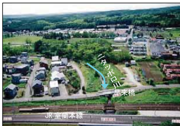
写真 1-20 ニタッポロ川下流域の状況（安平川合流点付近）
