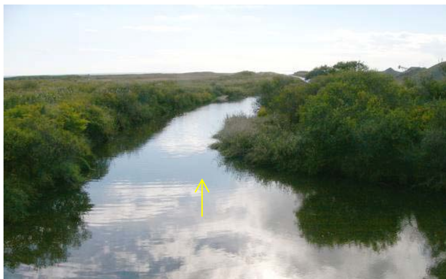
下流域の河道状況
