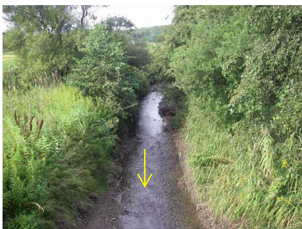
上流域の河道状況
