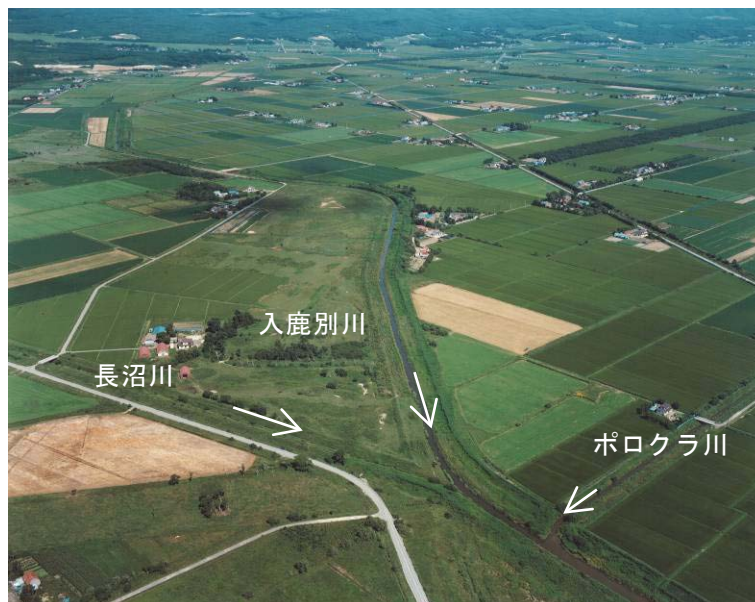
SP1200 支川合流点付近（下流域）
