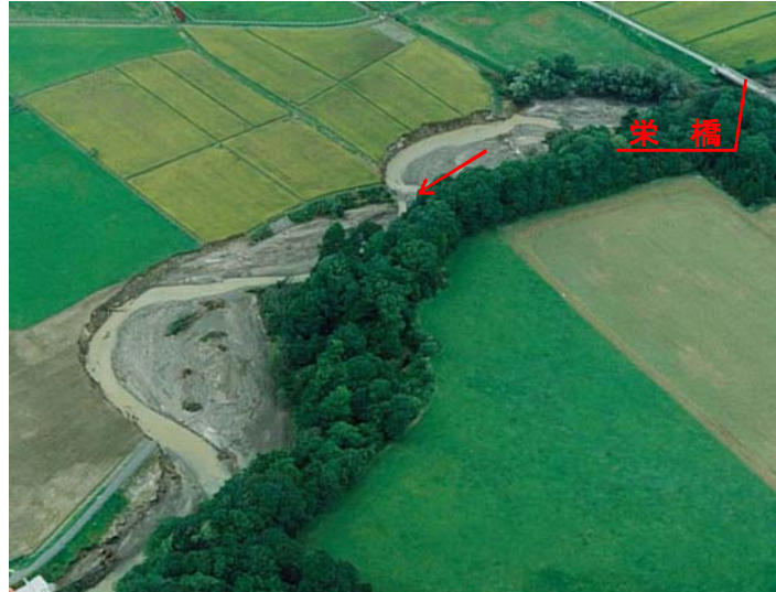
被災状況（栄橋下流付近）H13.9 撮影
