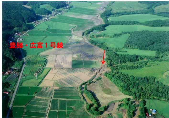
被災状況（豊郷上流地区）H15.8 撮影
