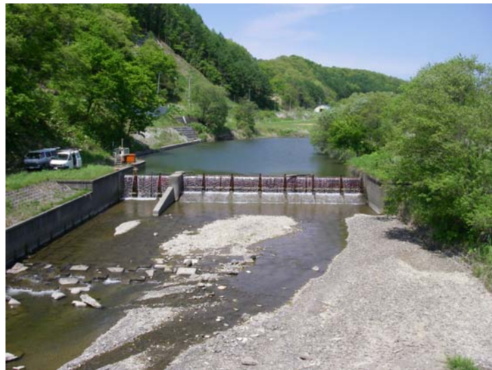
写真－１２ 頭首工による取水状況
