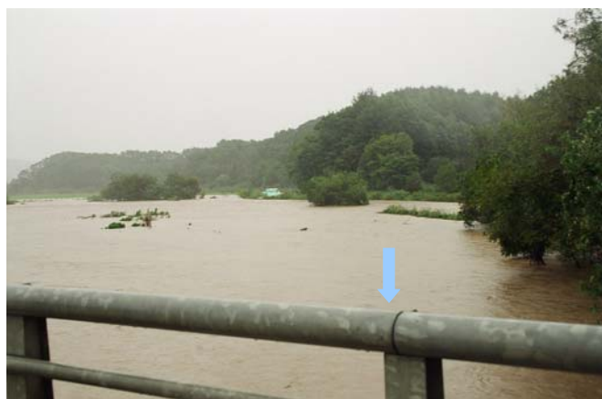
写真－7 農地冠水状況(平成13年9月)志美台橋上流
