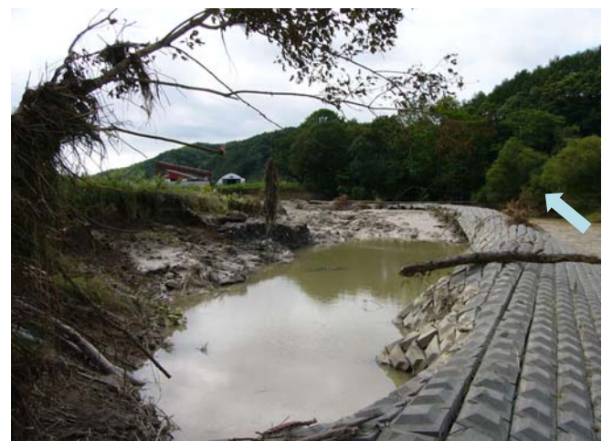
写真-11 農地被災状況(平成18年8月)SP15700付近
