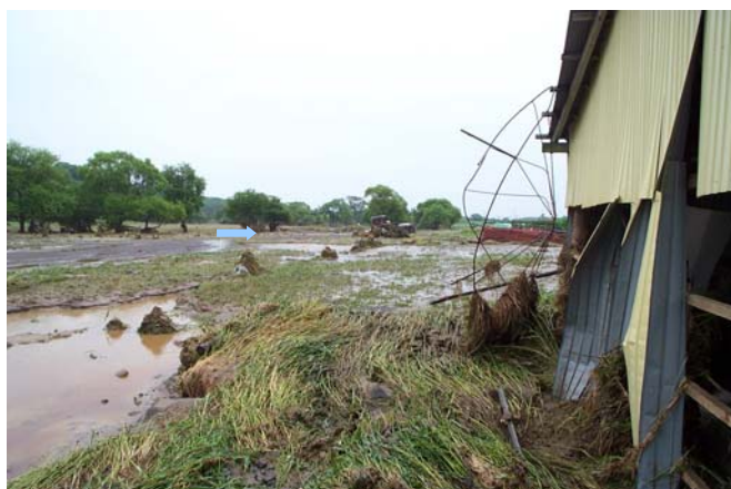
写真-8 農地被災状況(平成15年8月)国道門別橋上流
