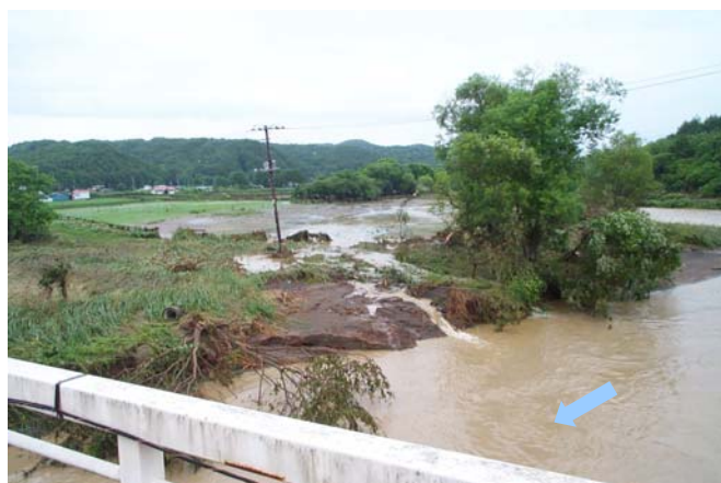
写真-9 農地冠水状況(平成15年8月)町道コタン橋上流
