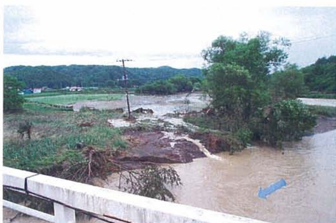
写真-11 農地冠水状況(平成15年8月) 町道コタン橋上流
