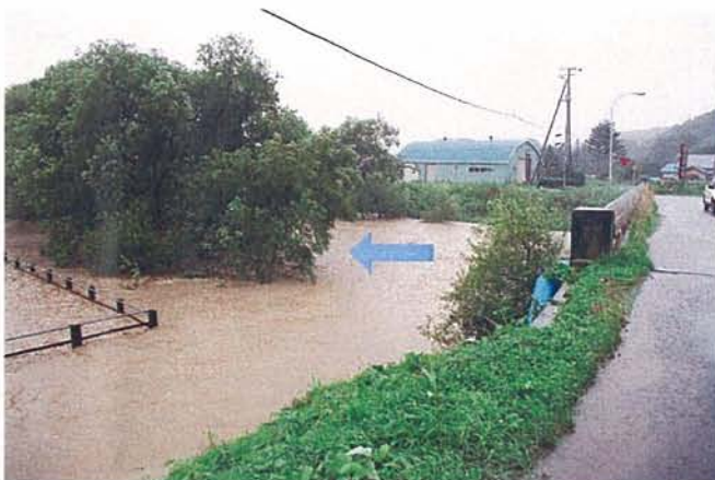
写真-4 農地冠水状況(平成13年9月) 幾千世橋下流
