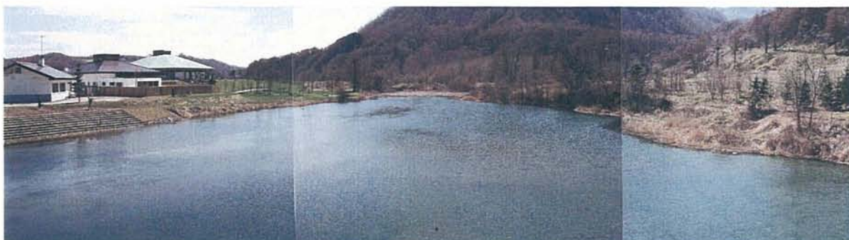
写真-17 新山沼地点 階段護岸
