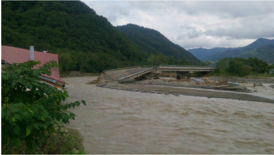
写真-5 平成28年(2016年)8月 台風第10号による被災状況 (千呂露橋付近 住宅半壊, 国道橋被災)
