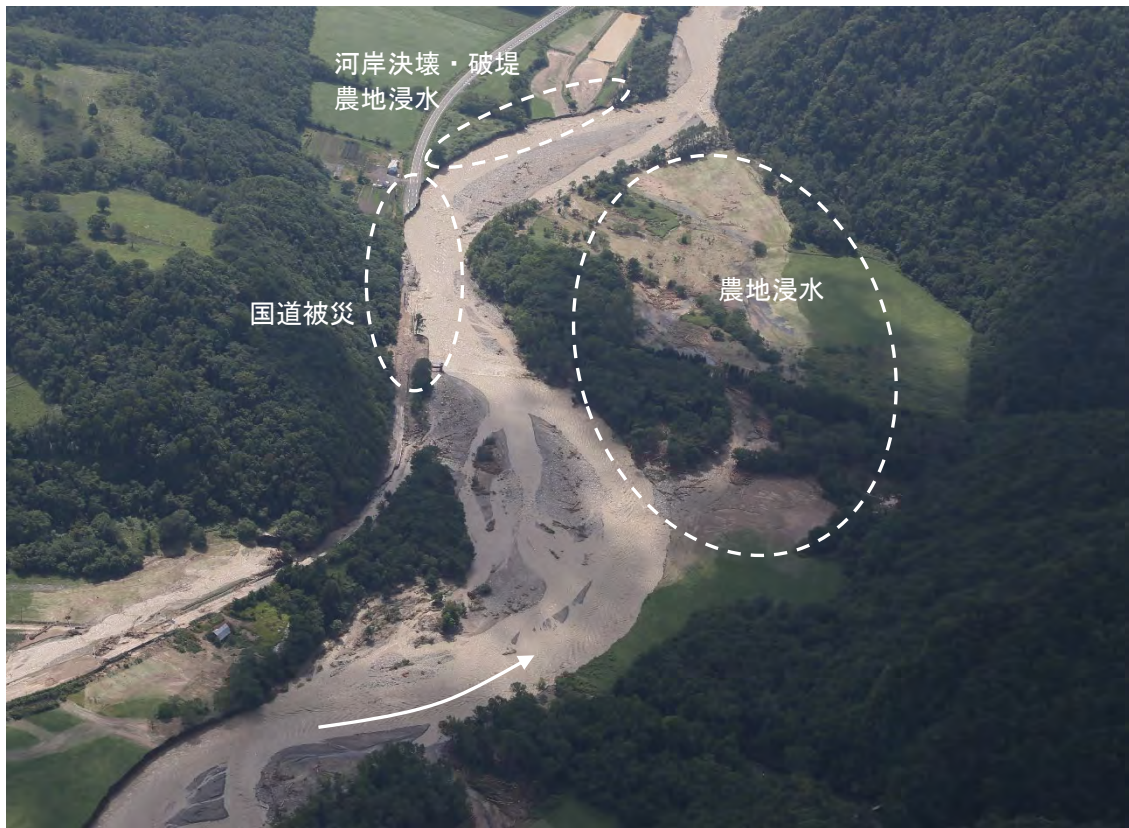
写真-4 平成28年(2016年)8月 台風第10号による被災状況 (日高町日高地区千栄 ひだか ひだか ちさか )
