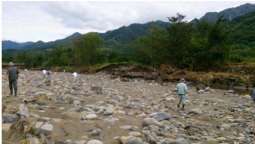
写真-6 平成28年(2016年)8月 台風第10号による被災状況 (千呂露小橋下流 左岸堤防破堤)
