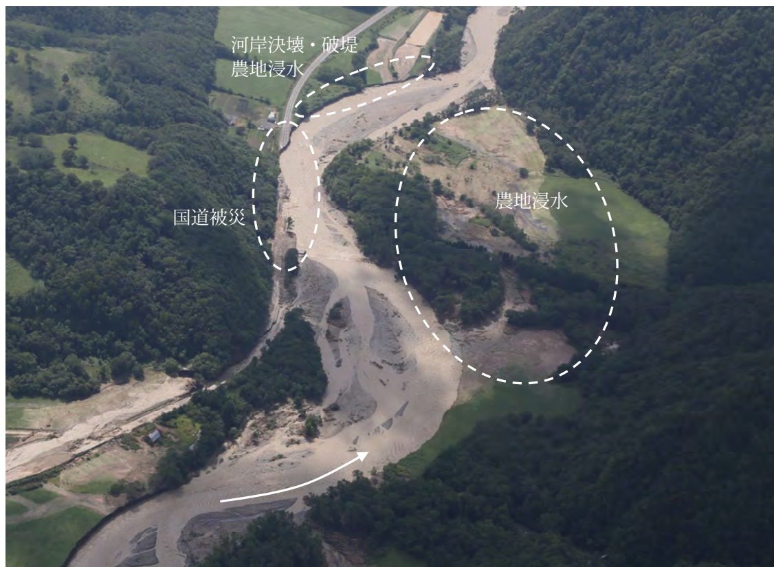
写真-3 平成28年8月 台風10号による被災状況 (ひだか ひだか ちさか 日高町日高地区 千栄)
