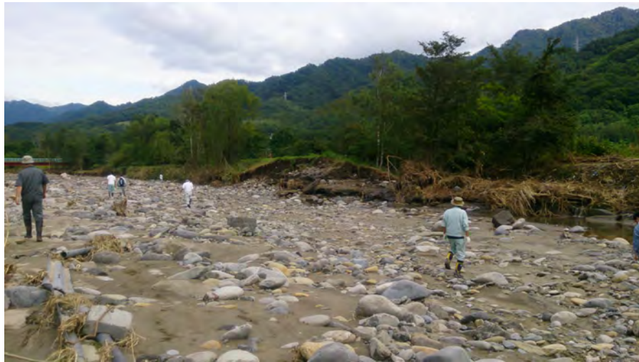
写真-5 平成28年8月 台風10号による被災状況 (千呂露小橋 ちるるこぼし 下流 左岸堤防破堤)
