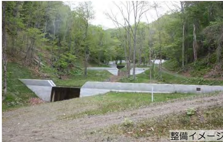
民有林内における治山ダムの整備
