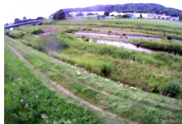
簡易型河川監視カメラによる映像提供（向別川）
