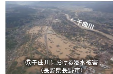
【令和元年東日本台風】
