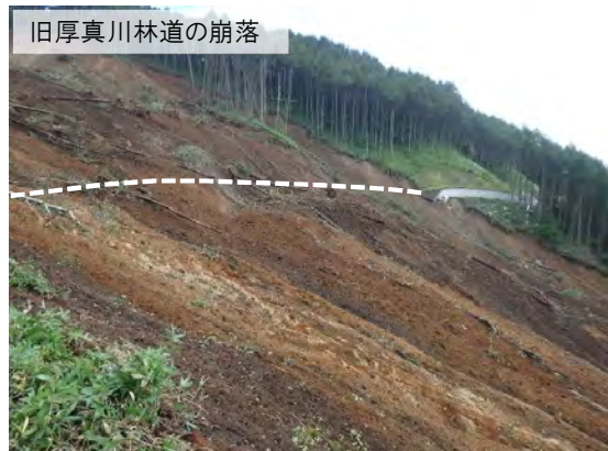
旧厚真川林道の崩落
