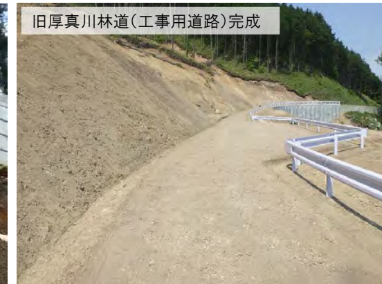
旧厚真川林道(工事用道路)完成
