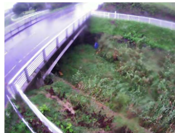
簡易型河川監視カメラによる映像提供（板谷川）
