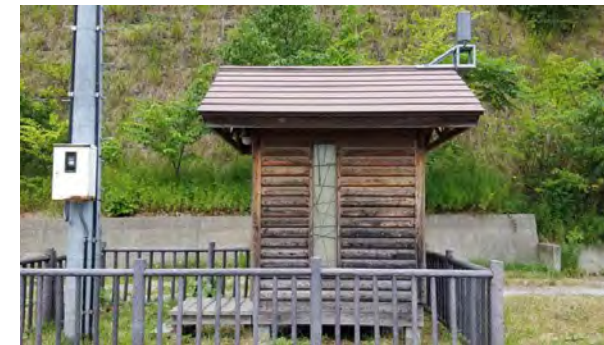
水位・雨量観測データの提供
