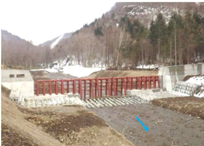
（紋別川）砂防堰堤の整備
