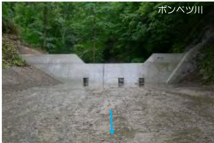
国有林内における治山ダムの整備 （胆振東部森林管理署）
