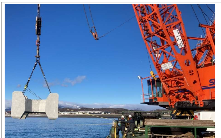
着手前（施工状況）
