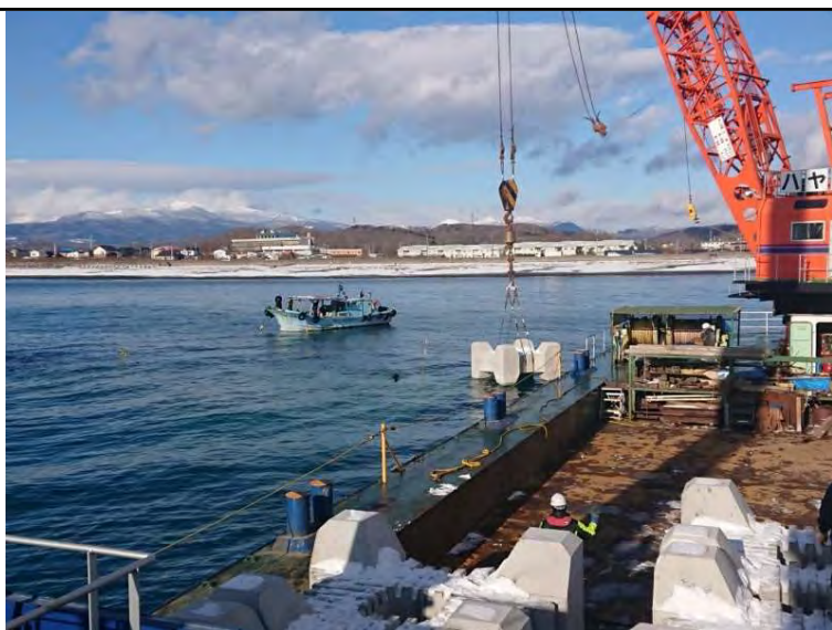
着手前（施工状況）
