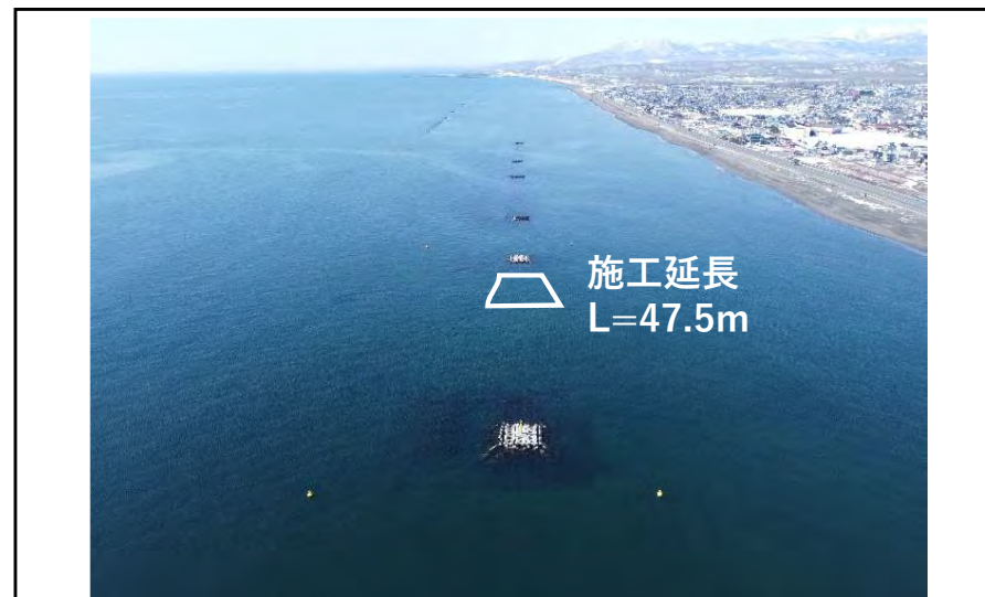
実施後（工事中）
