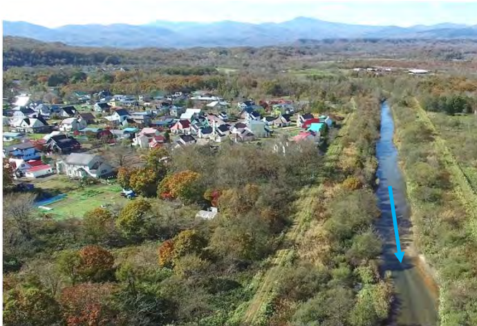
（ウヨロ川）河道掘削等の実施
