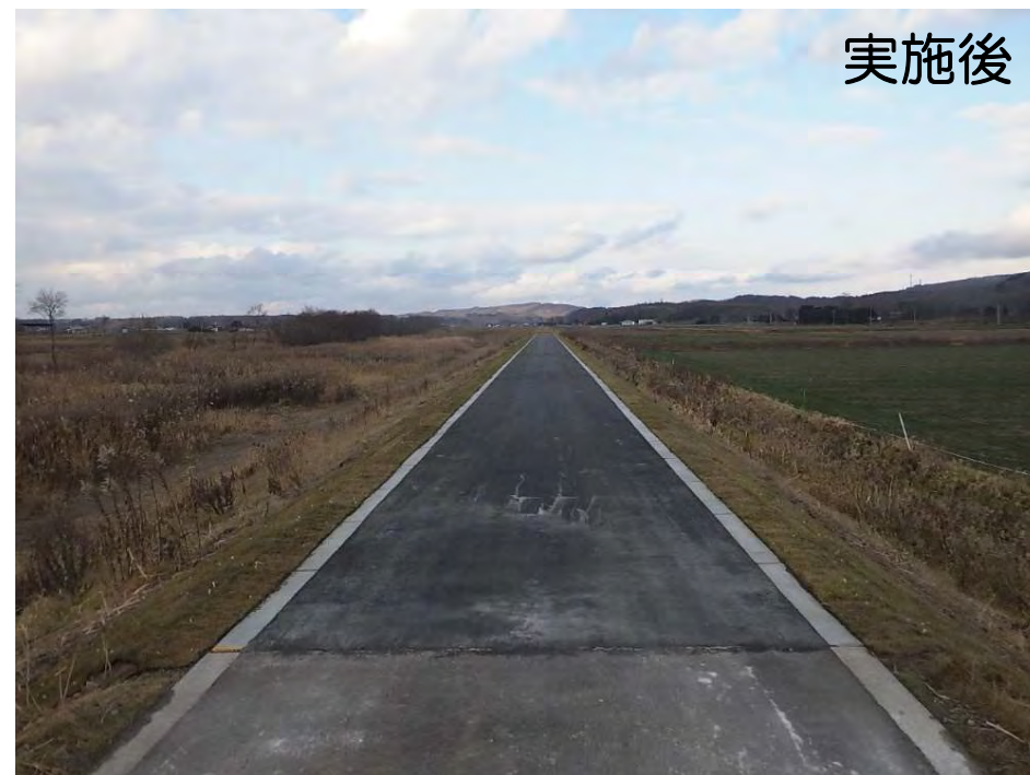
天端舗装（粘り強い構造の堤防）
