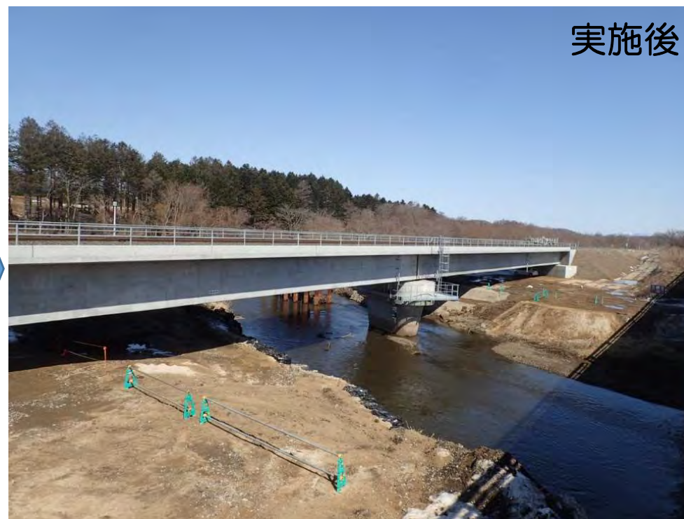
第1安平鉄橋（JR橋）
