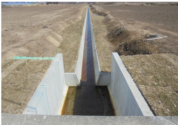
農業排水路の整備
