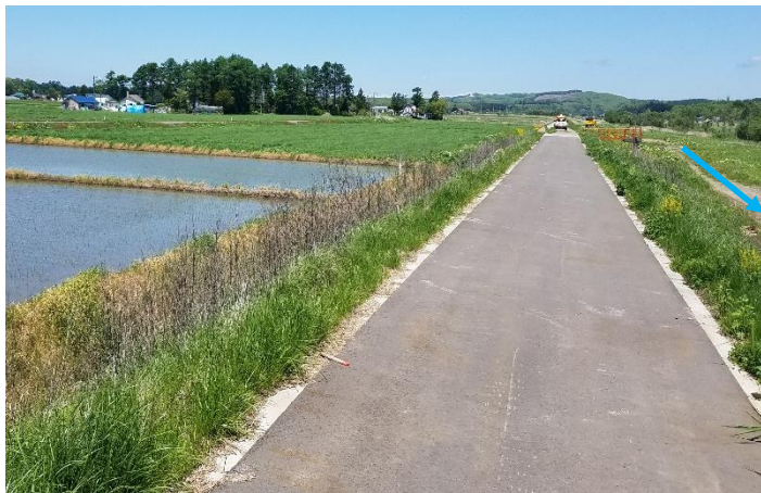
(安平川) 堤防天端舗装の実施
