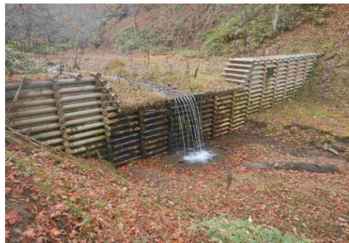
道有林内における治山ダムの整備
