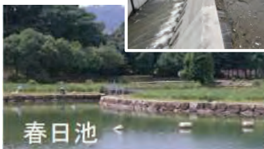
洪水時の放流状況
