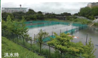
【事例：霧が丘調整池(横浜市)】
