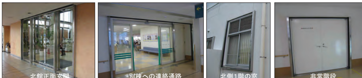
止水板のための角落しの設置
