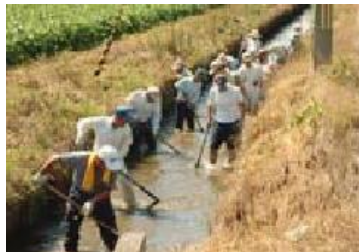
〈水路の泥上げ〉
