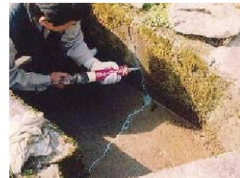
〈水路のひび割れ補修〉
