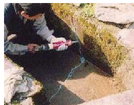
〈水路のひび割れ補修〉
