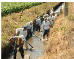
〈水路の泥上げ〉
