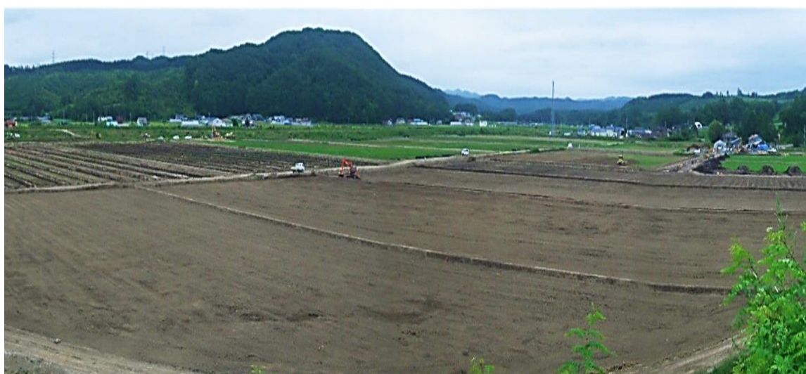
東和地区 区画整理の様子(上:整備前、下:整備後)
