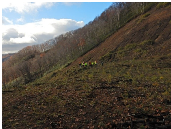
崩壊斜面は、土がむき出しのまま、手前の崩壊土砂の堆積地には、今年カラマツを植林しました。
