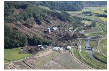
浄水場の被害（厚真町）
