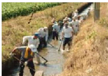
＜水路の泥上げ＞
