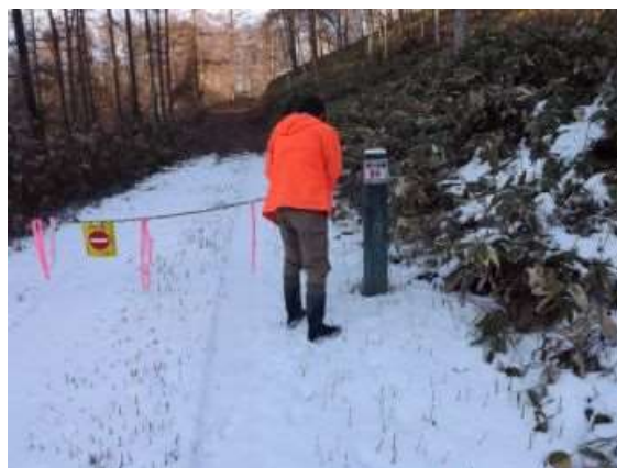
林道ゲートの補修
