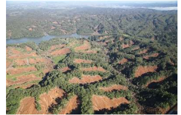
大規模な土砂崩れ (安平町)
