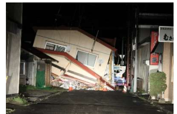
商店街の被害 (むかわ町)
