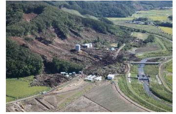
浄水場の被害 (厚真町)
